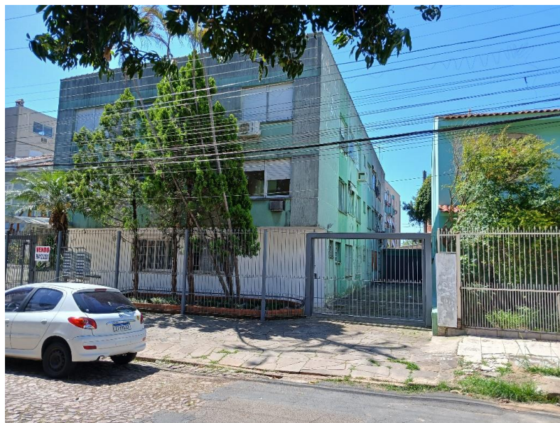
Figura 1: Fachada do Edifício
