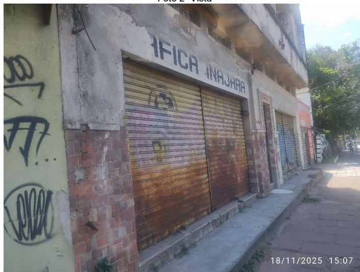
Fonte: Vistoria em 18/11/2025
