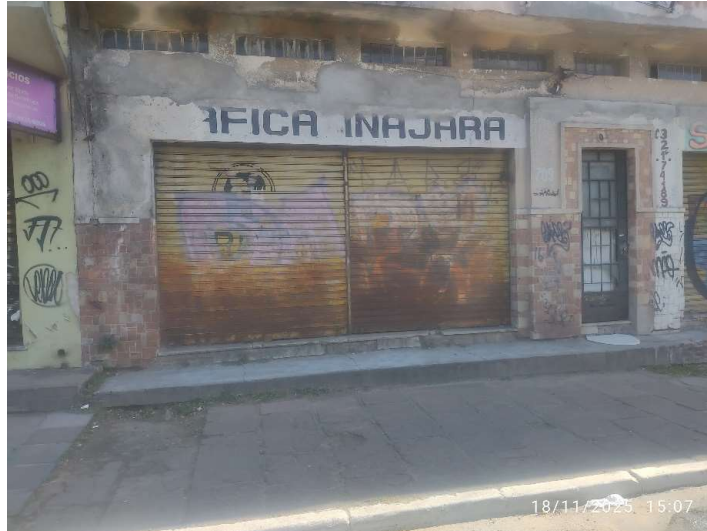
Fonte: Vistoria em 18/11/2025
