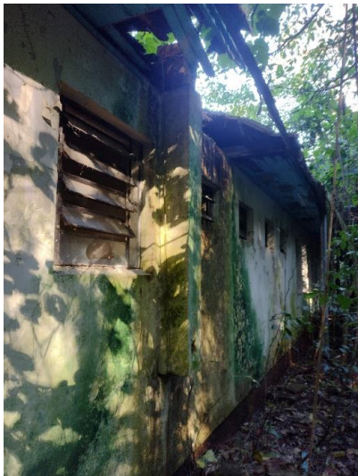
Figura 3: vista parcial do imóvel. Fonte: DIAVA (24/07/2024)
