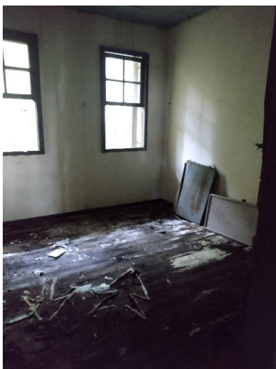
Figura 5: Vista interna da edificação principal. Fonte: DIAVA (24/07/2024)
