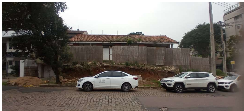
Figura 1: Fachada Rua Acélio Daudt
