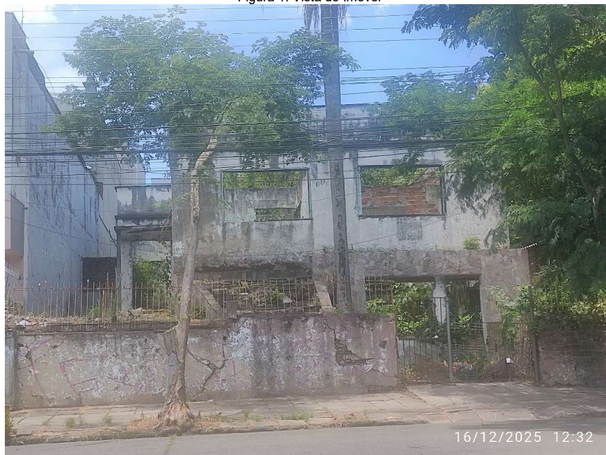
Figura 1: Vista do Imóvel
