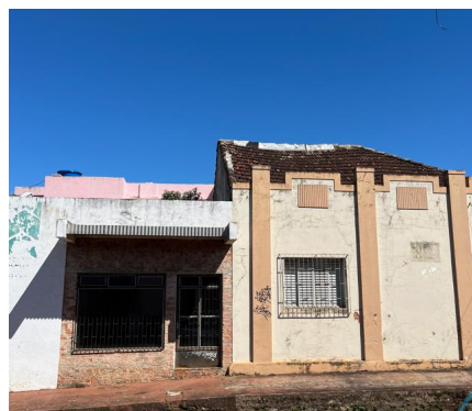
Figura 6: Telhado do imóvel
